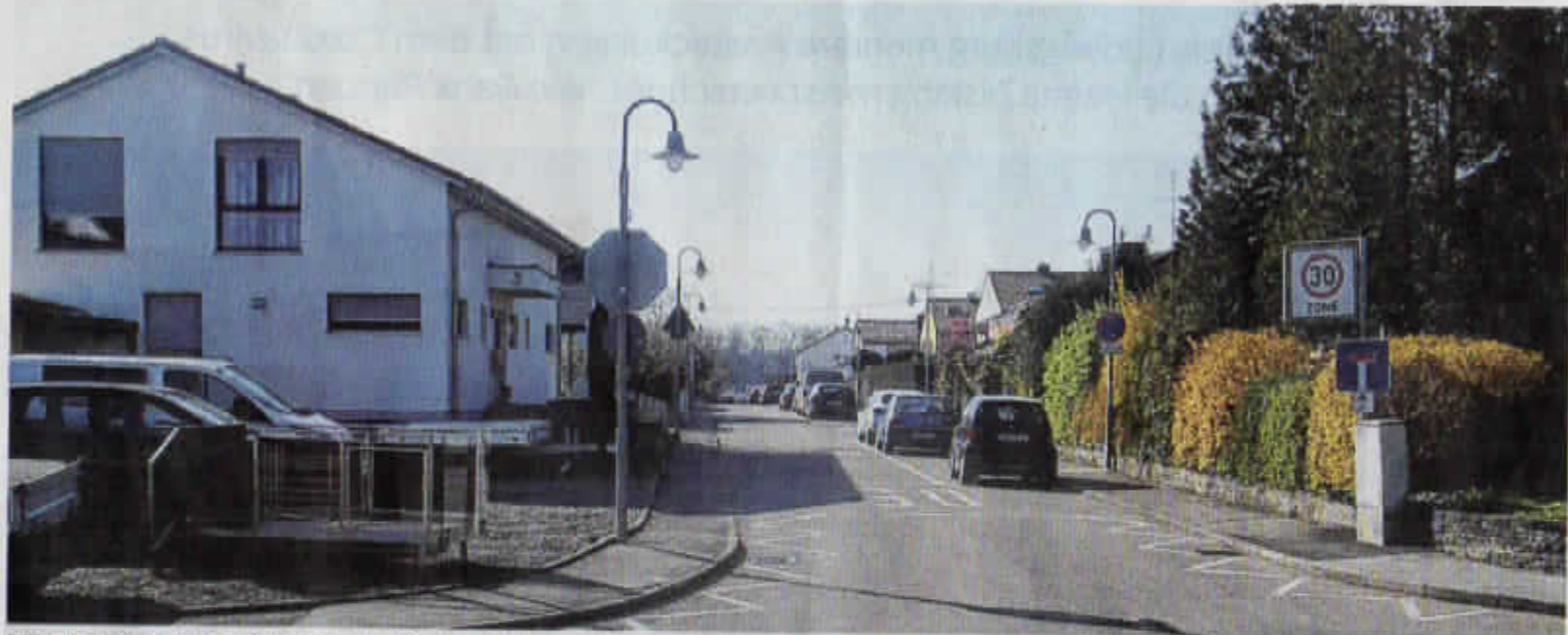
Die Einfahrt in die Sackgasse in den Beeten in Ingersheim von der Besigheimer Straße aus. Bislang parken Fahrzeuge auf der rechten Seite. Künftig sollen Parkplätze auf beiden Seiten wechselseitig angelegt werden.
